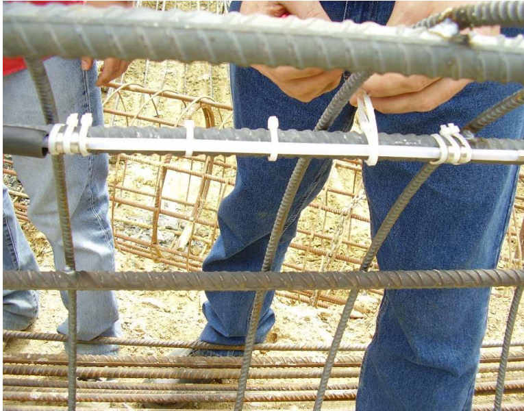
FIG. 8 – INSTALLAZIONE DI UN SENSORE SU UN PALO DI FONDAZIONE
