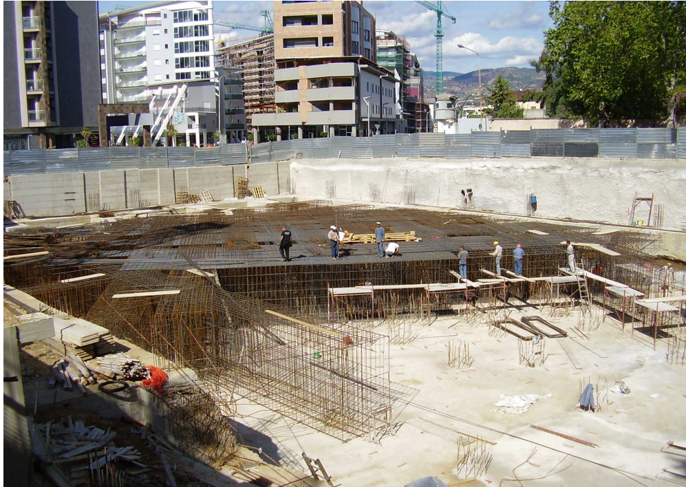
FIG. 3 – REALIZZAZIONE DELLA FONDAZIONE
