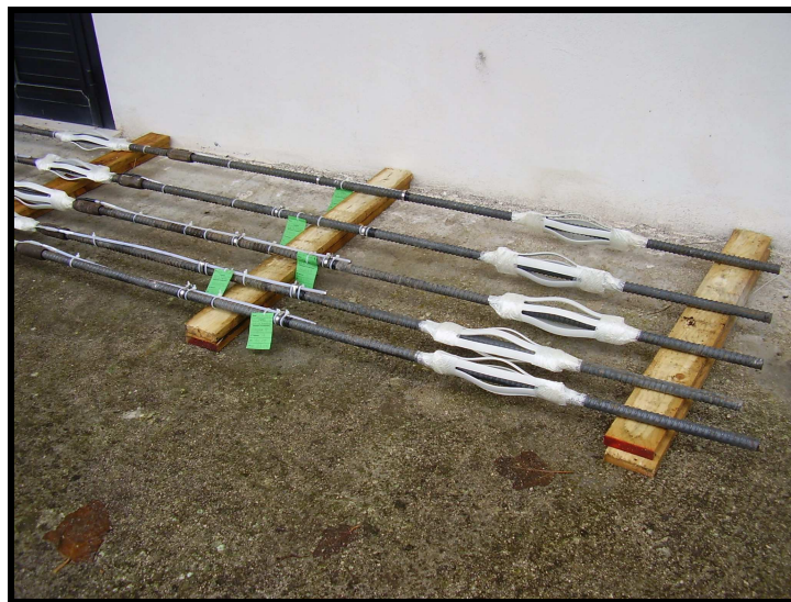
Fig. 7 – Barre di ancoraggio pronte per essere inserite nei fori di perforazione
