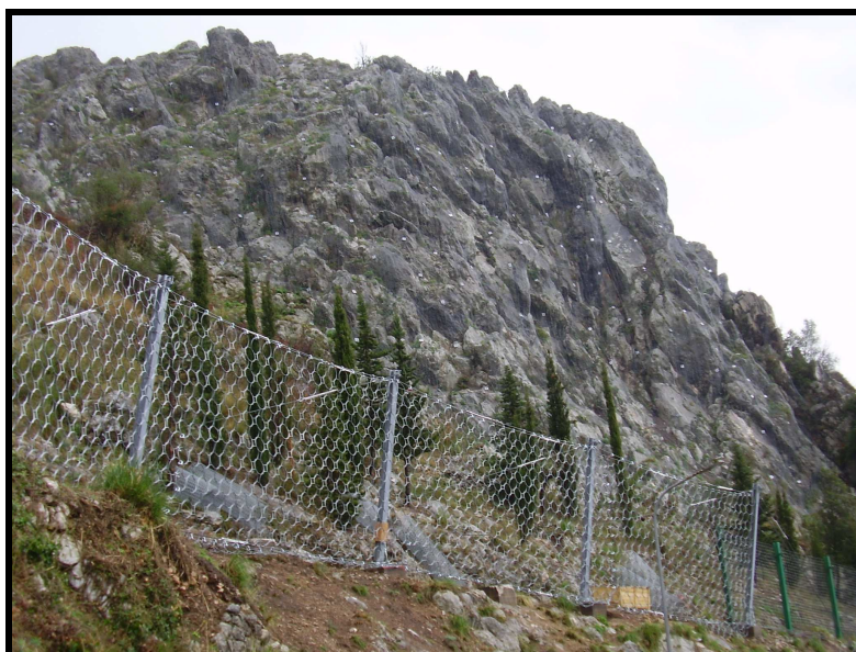
Fig. 4 - Costone roccioso stabilizzato con barre di ancoraggio
