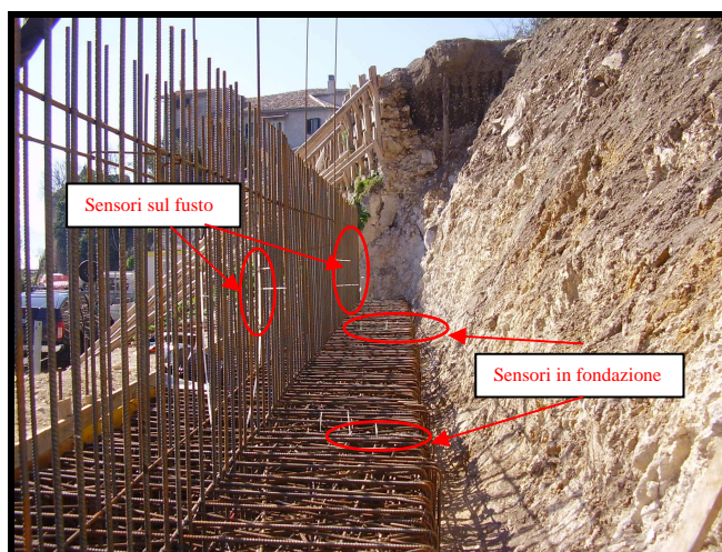
Fig. 9 – Fase di installazione di sensori a fibra ottica su un muro di sostegno
