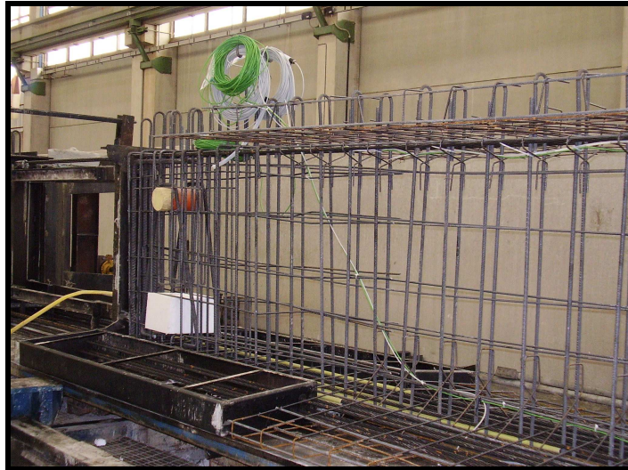
Fig. 12 – Posizionamento dei sensori sui trefoli di precompressione in stabilimento
