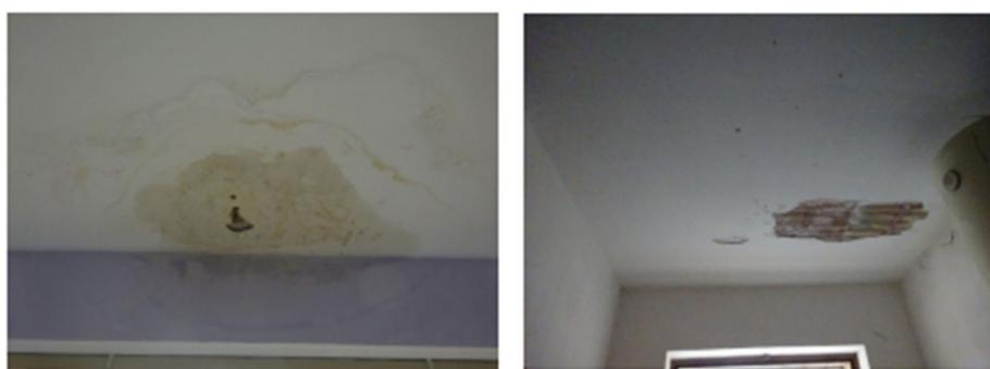
Foto 13 – Presenza di Quadri Fessurativi, umidità e distacco di Intonaco.
