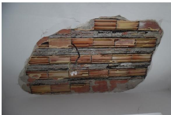
*Figura 6 - Sfondellamento su un solaio gettato in opera.*
