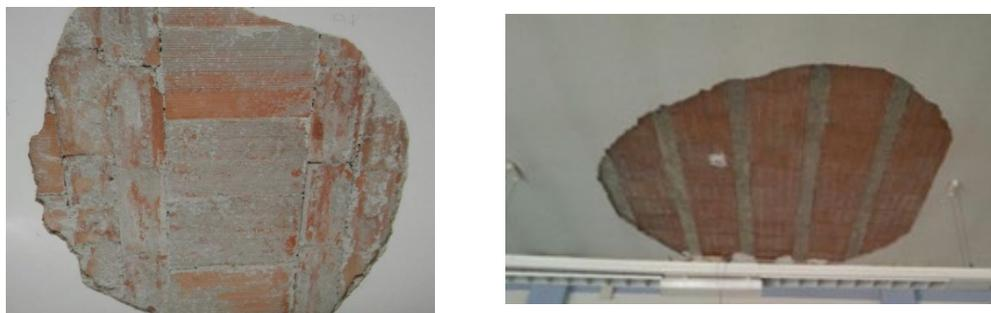
*Figura 9 - Distacco di intonaco su un solaio gettato in opera e su un solaio con travetti in c.a.p.*
