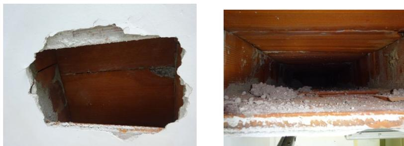
*Figura 7 - Danneggiamento tavella inferiore su un solaio SAPAL.*
