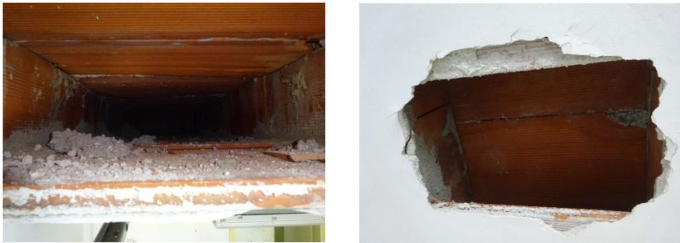
Fig. 7. Danneggiamento tavella inferiore su un solaio SAPAL.
