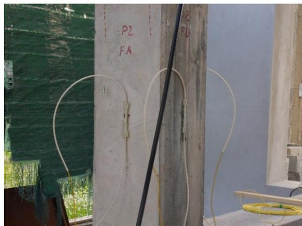
Fig. 6. Installazione sensori OBSG-120.
