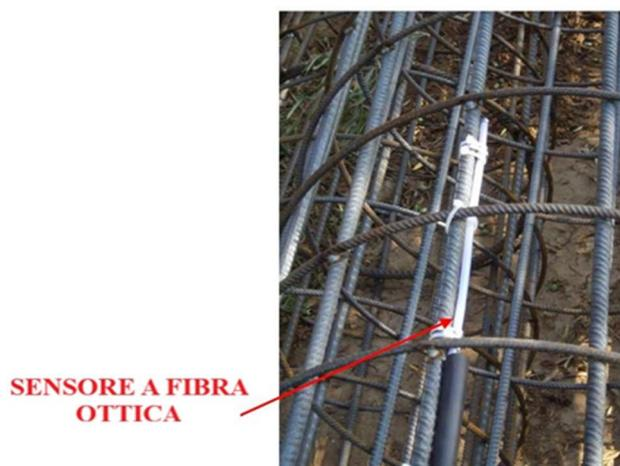
Figura 13. Installazione di un sensore su un palo
