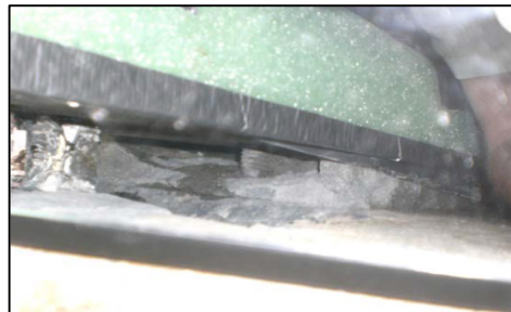
Figura 8-Vuoti all'interno della malta [5]
