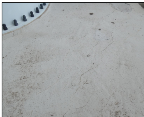
Figura 11-Quadro fessurativo diffuso
