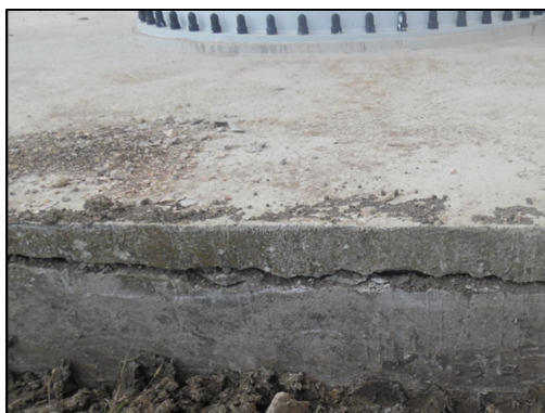
Figura 22-Esemplio 1, livello alto di danno
