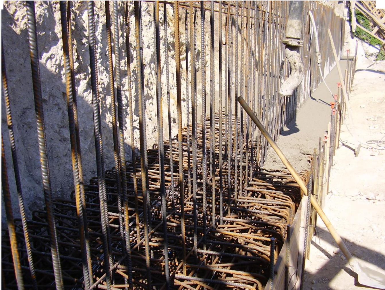
Fase di getto del calcestruzzo in fondazione
