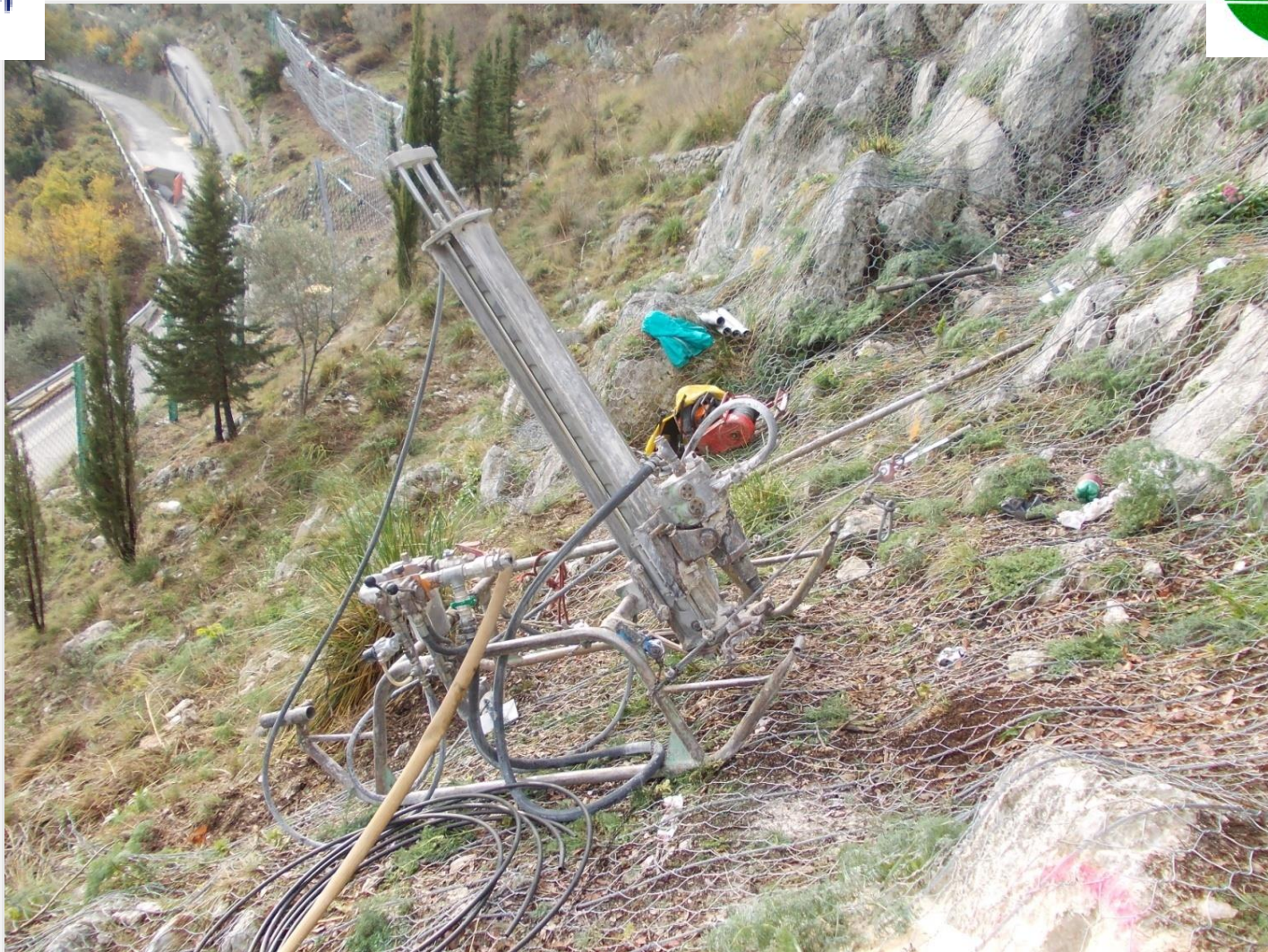
Predisposizione fori per barre di ancoraggio
