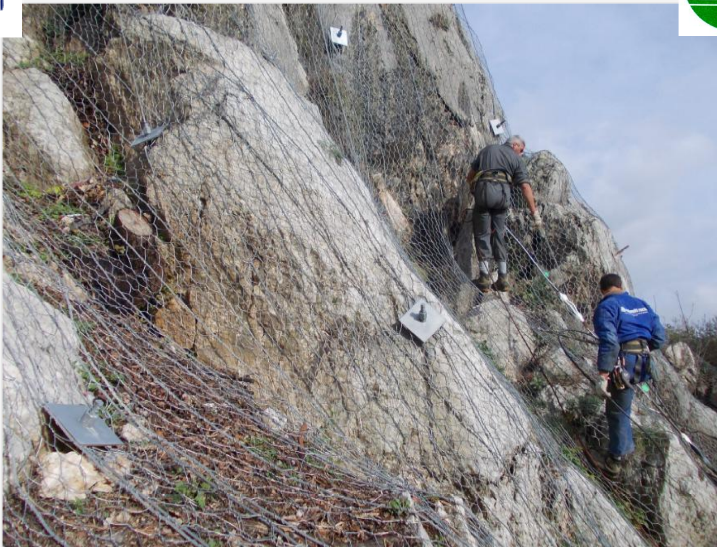
Fase di messa in opera delle barre
