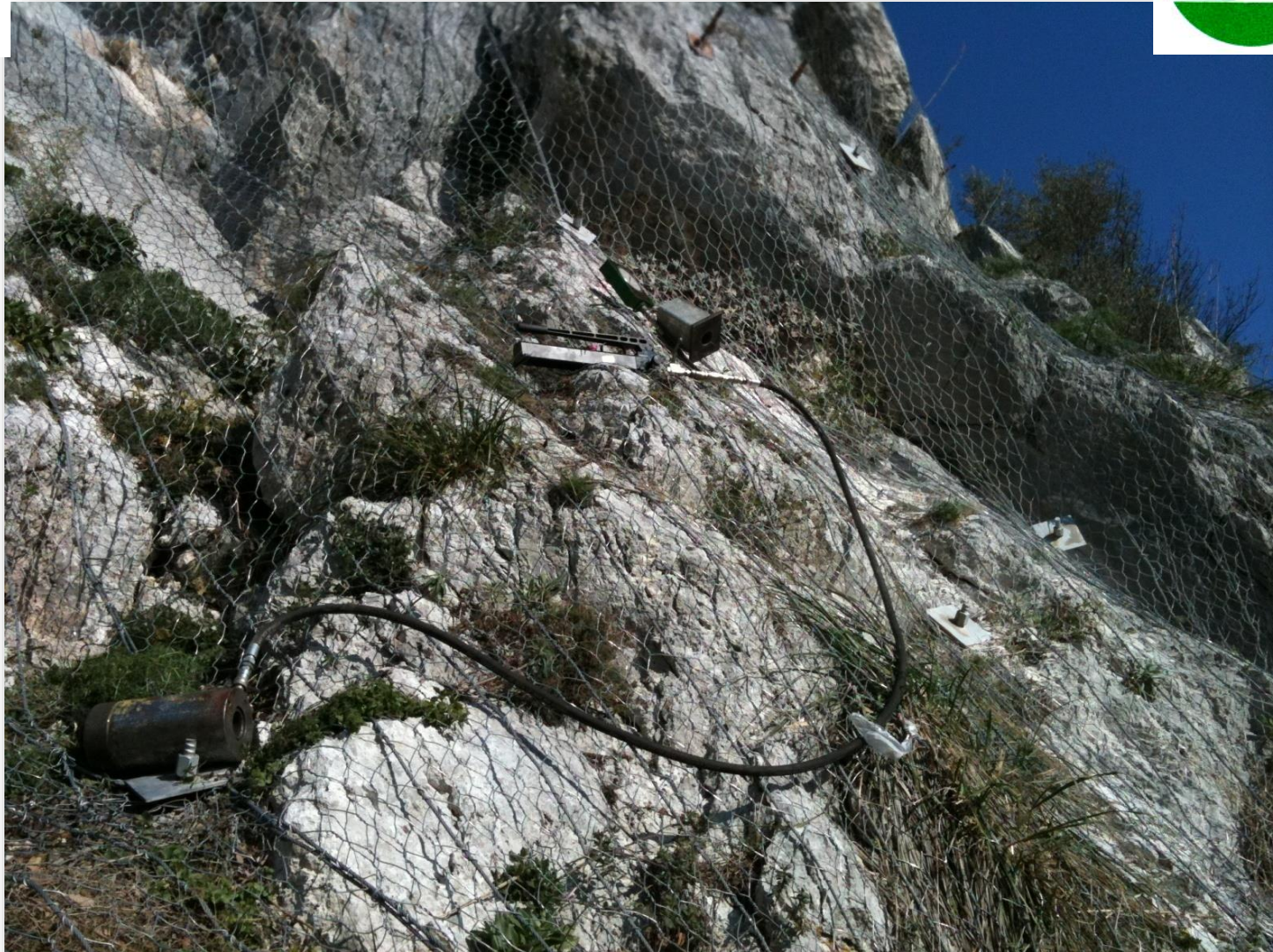
Fase di tiro delle barre
