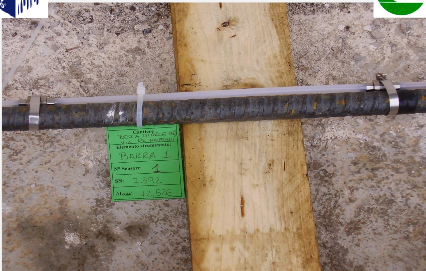
Barra di ancoraggio n°1 - installazione sensore a fibra ottica N.1
