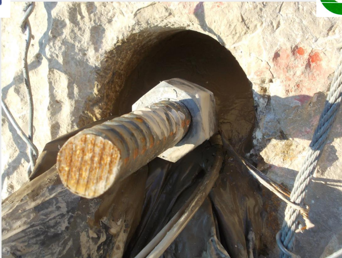
Fase di iniezione delle barre
