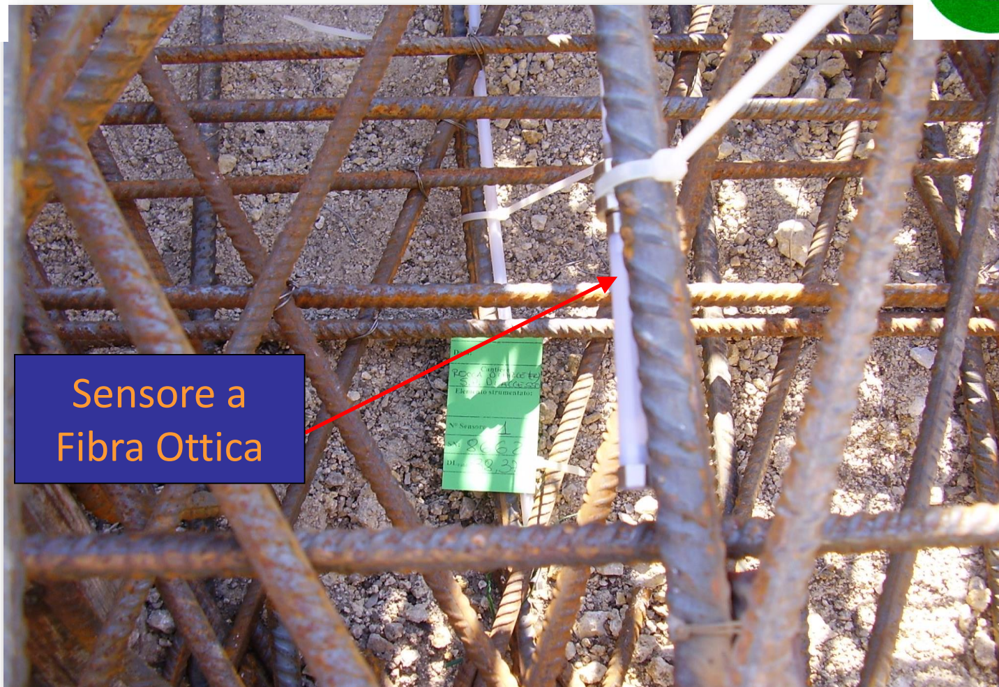
Fase di installazione dei sensori in fondazione
