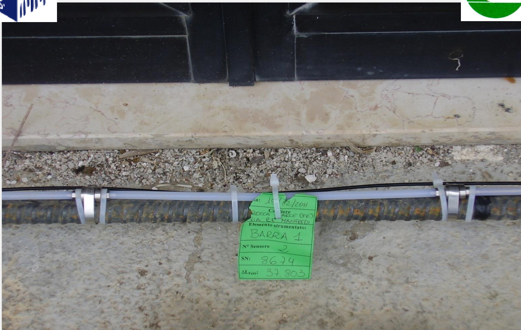
Barra di ancoraggio n°1 - installazione sensore a fibra ottica N.2
