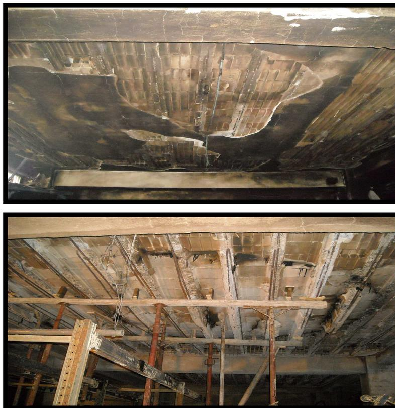
*Fig. 6 - Effetti del carico di incendio sui solai in sequenza dall'alto verso il basso lieve – medio - alto*
