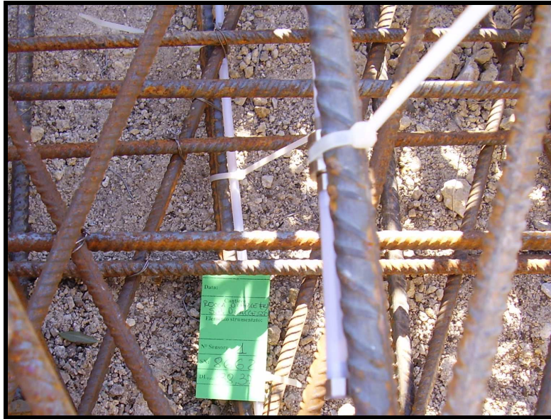
Fig.15 – Fasi di installazione dei sensori in fondazione.
