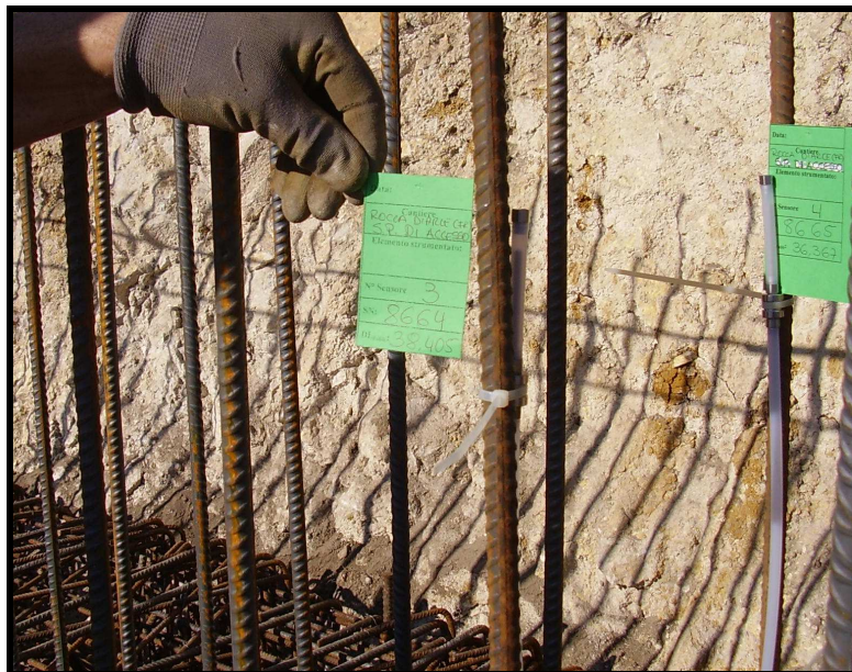
Fig.16 – Fasi di installazione dei sensori sulle armature del fusto di paramento interno ed esterno.
