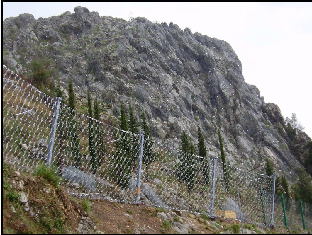
Fig. 1 - Costone roccioso stabilizzato con barre Dywidag e rete a doppia torsione.
