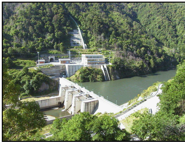
Figura n°1 - Centrale idroelettrica di Satriano (CZ)
