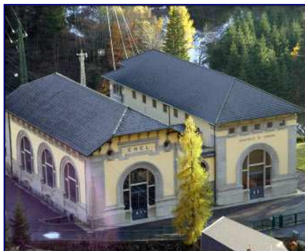
Figura n°2 - Centrale idroelettrica di Carona (BG)
