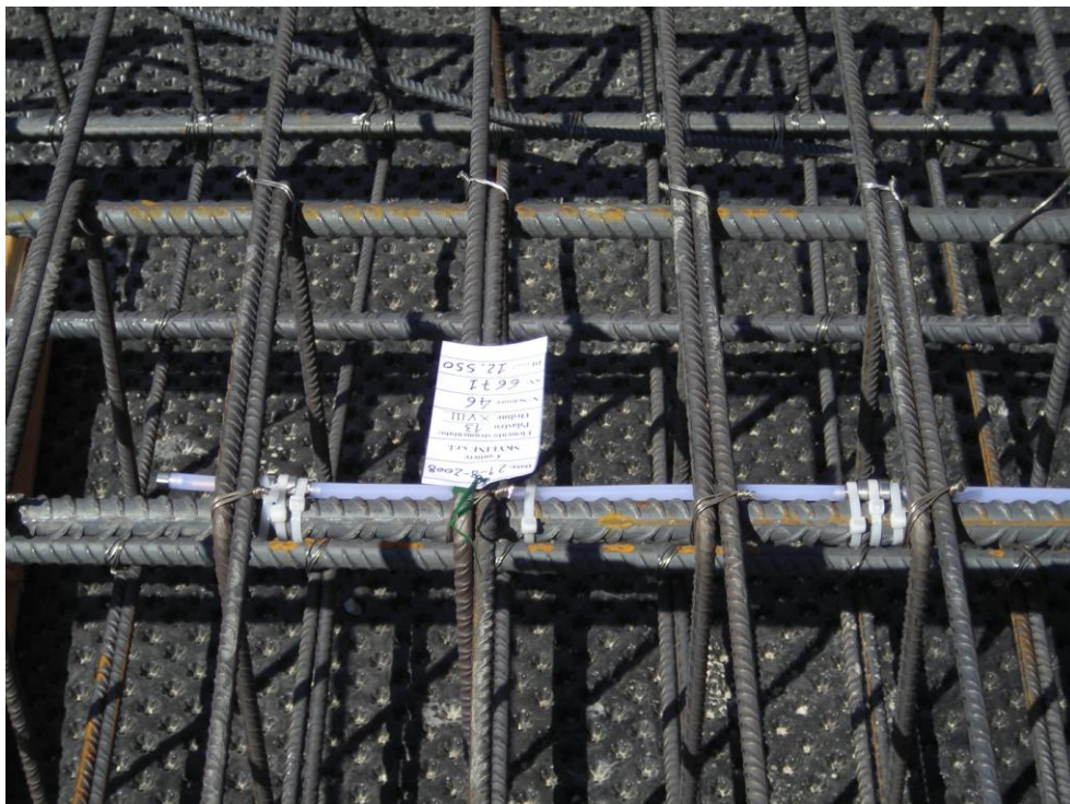
PILASTRO STRUMENTATO (XVIII ORDINE)
