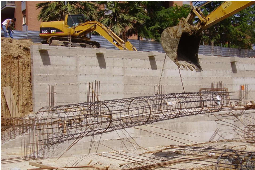
POSA IN OPERA DELLE ARMATURE MONITORATE
