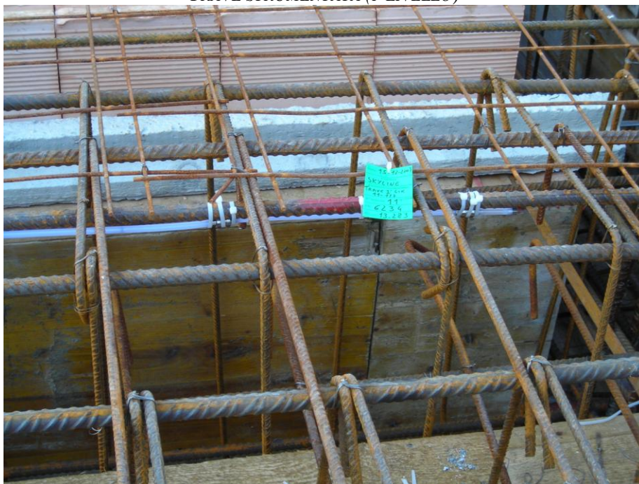
TRAVE STRUMENTATA (1 LIVELLO)
