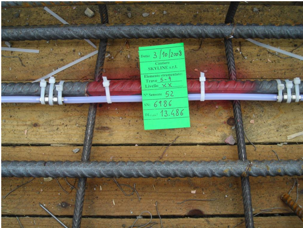
TRAVE STRUMENTATA (XX LIVELLO)
