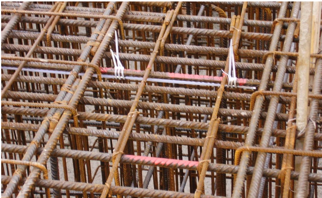
INSTALLAZIONE DEL SENSORE SU UNA TRAVE DI FONDAZIONE
