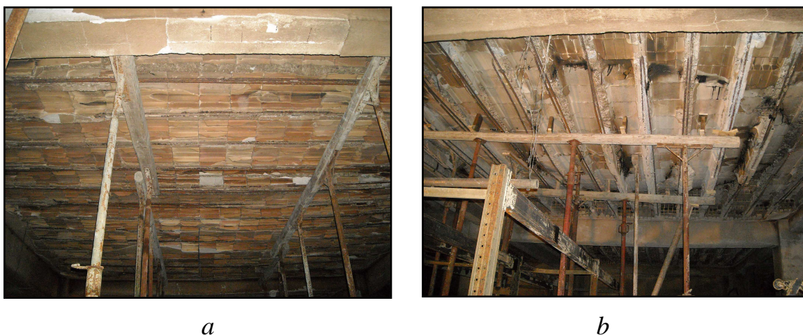
Fig. 2. a,b – Fasi di messa in sicurezza
