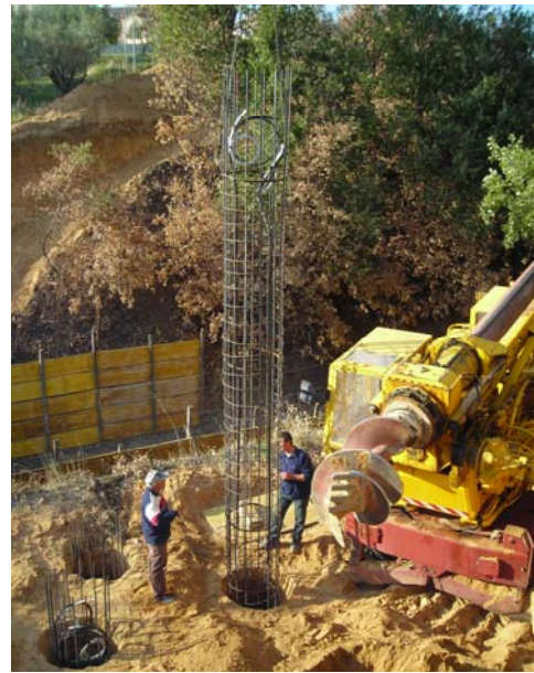
Foto 1 - Varo dell'armatura
